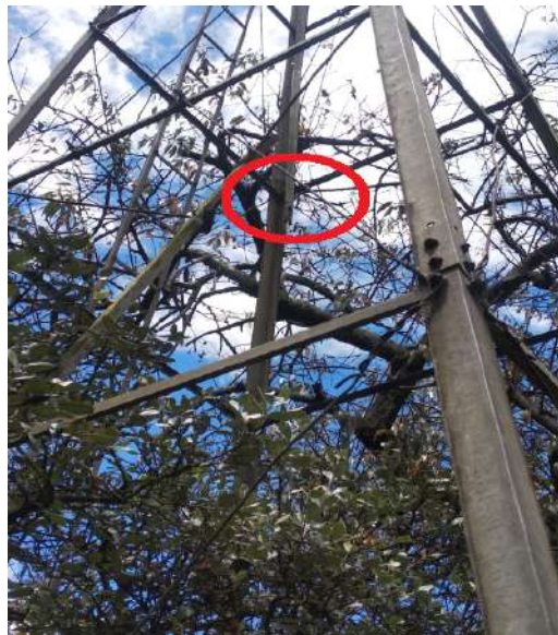
Foto No. 4. Sistema de extracción desconectado
