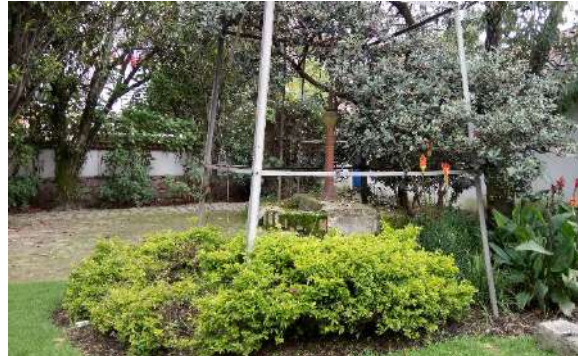
Fotografía 4. Tubería de producción y base del molino.
