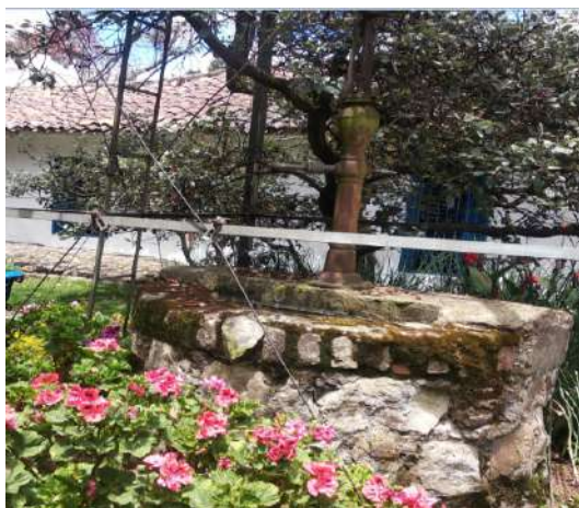
Foto No. 3. Vista general del aljibe aj-11-0189
