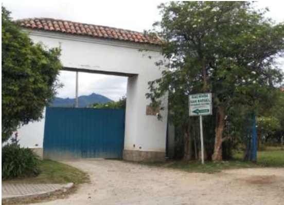
Foto No. 1. Fachada del predio
