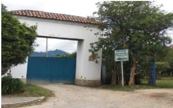
Foto No. 1. Fachada del predio
